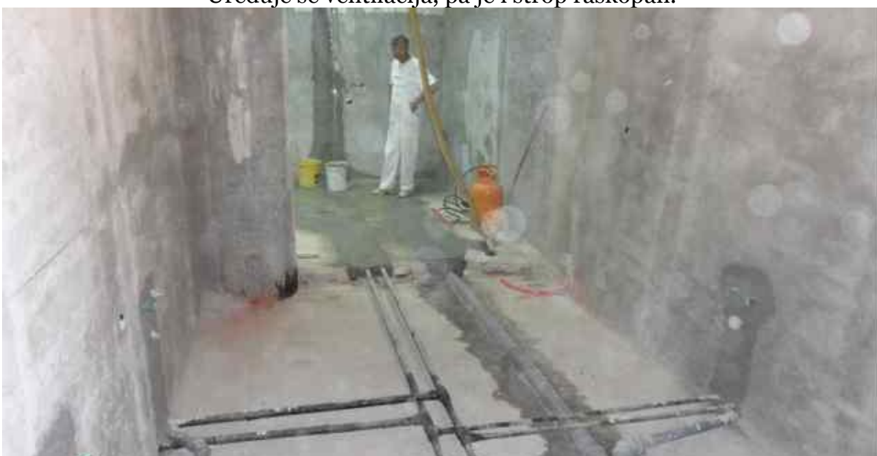
Ovo su izlazne cijevi iz kuhinje koje majstori betoniraju.
