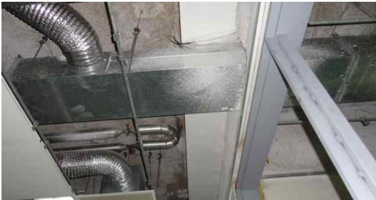
Uređuje se ventilacija, pa je i strop raskopan.
