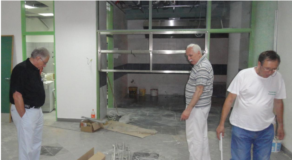
Radovi u đlačkoj kuhinji su pred završetkom.
