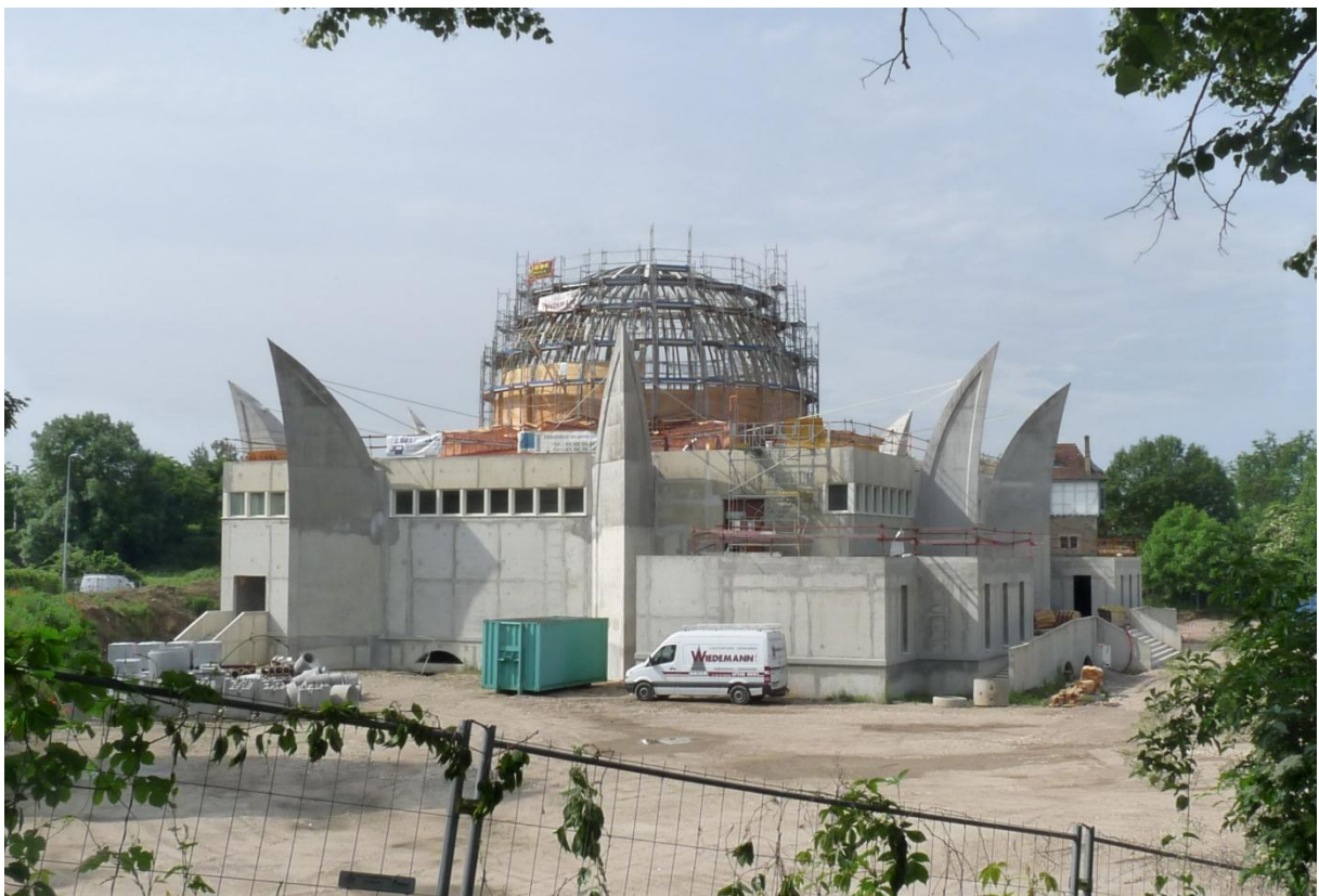
Velika džamija u Strazburu u izgradnji
